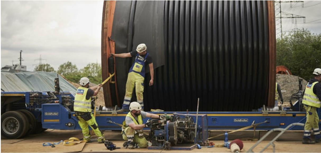
Die Kabel sollen mit Isolierung einen Durchmesser von mehr als 20 Zentimetern haben und in die Röhren gezogen werden. Amprion GmbH
